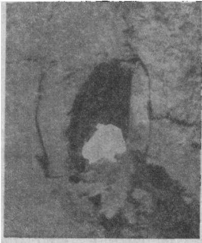
照片 1 乌栅土暗洞已经使用 8 年(1967—1975 年) 洞壁未塌,孔道贯通
